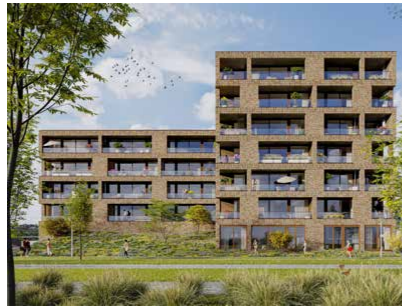
Balkons binnen het gebouw
